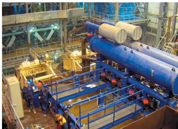
Отсадка сдвоенной alljig® на ОФ «Северная»
